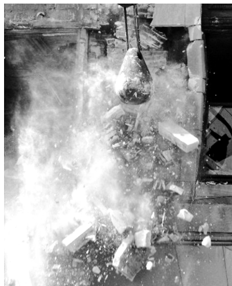
slopen met een sloopkogel
